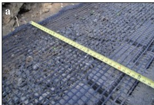
شکل ۱. (a) ژئوگرید (b) استفاده از ژئوگرید در تقویت خاک در محل یک پروژه ژئوتکنیکی Fig. 1. (a) Geogrid (b) the application of geogrid for reinforcement of soil in a geotechnical project
