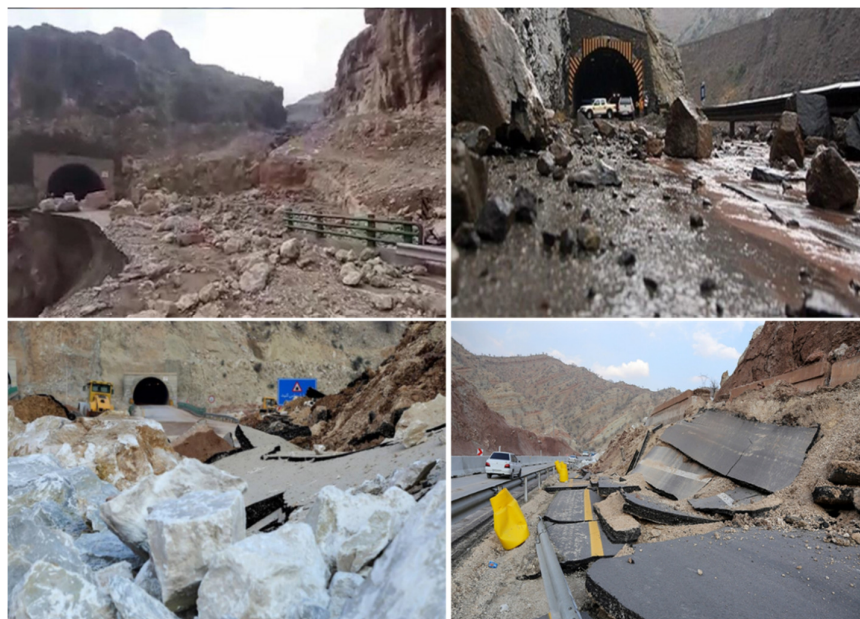
شکل ۲. برخی از زمین‌لغزش‌های اتفاق افتاده در طول مسیر آزادراه خرم‌آباد-زال
