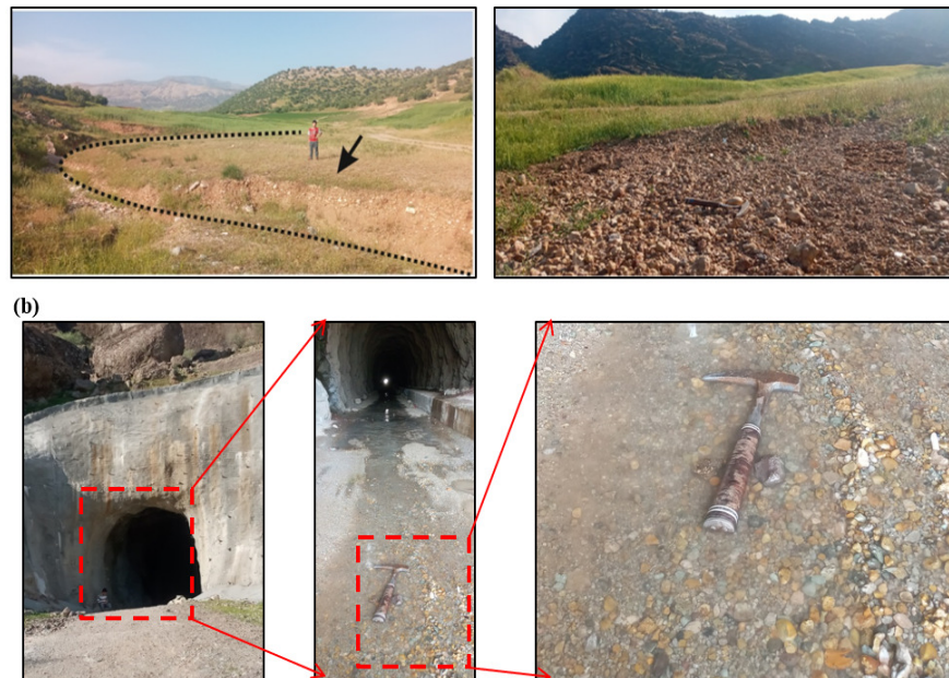
شکل ۲۵. (a) رسوبات حاصل از تأثیر فرسایشی آب روی کنگلومرا و پوینت‌بارهای رودخانه و (b) رسوبات حاصل از فرسایش کنگلومراهای سقف دیوار تونل به دلیل نشت و جریان آب در امتداد سطوح شکستگی و لایه‌بندی و همچنین قطعات حاصل در طی عملیات حفاری و ساخت تونل Fig. 25. (a) Sediments resulting from the erosive effect of water on the conglomerate and point bars of the river and (b) sediments resulting from the erosion of conglomerate in the roof and faces of tunnel due to leakage and water flow along fractures and bedding surfaces as well as the resulting parts during the tunnel excavation and construction operations
