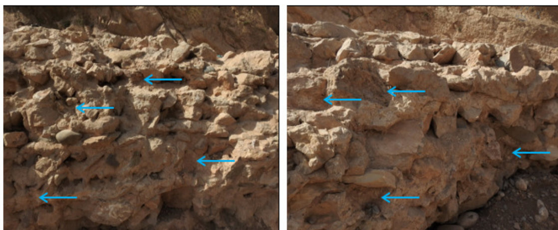
شکل ۳. فرسودگی و تخریب راه باستانی گاشمار به دلیل عوامل هوازدگی (برخی از آثار فرسودگی با فلش آبی نشان داده شده‌اند) Fig. 3. Deterioration and decay of the ancient road of Gashmar due to weathering agents (some signs of deterioration are shown with blue arrows)
