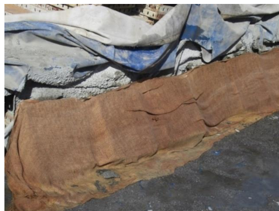
شکل ۸. ایجاد شرایط مرطوب با گونی نمدار بر روی پنل‌ها پس از پاشش شاتکریت
