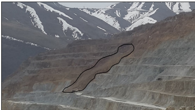
شکل ۱۲. ریزش روی داده در شهریور ماه ۱۳۹۵ در مصالح پیروکلاستی
