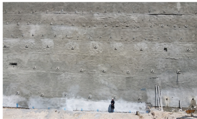
شکل ۱۵. پایدارسازی توسط سیستم ترکیبی مهاربندی و میخ‌کوبی - ضلع شرقی پروژه نگین ولیعصر تبریز
