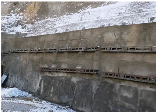
شکل ۲۵. پایدارسازی سمت شرقی دیواره جنوبی گود نگین با سیستم شمع و انکر
