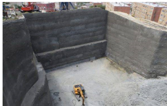
شکل ۱۹. پایدارسازی دیواره‌های گود تاوریز توسط سیستم میخ‌کوبی و انکراژ
