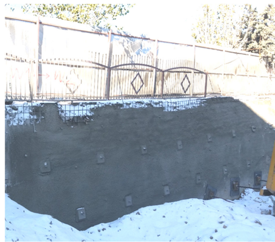
شکل ۲۴. پایدارسازی دیواره غربی پروژه نگین با استفاده از سیستم میخ‌کوبی
