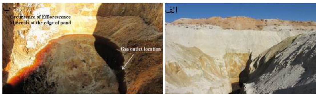
شکل ۶. الف- ترانشه ایجاد شده در معدن ب- حوضچه آب زیرزمینی به شدت اسیدی، خروج گاز از آن و رسوب کانی‌های شورهای
