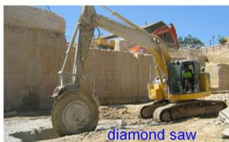
شکل ۱. استفاده از اره‌های الماسه دیسکی به منظور برش سنگ
