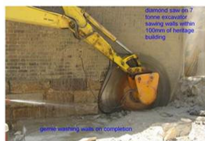
شکل ۱. استفاده از اره‌های الماسه دیسکی به منظور برش سنگ
